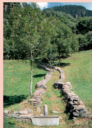
...und nach Instandstellung
