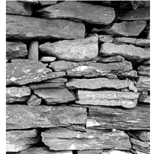
Ausschnitt aus dem Fundament des Blockbaus als Beispiel typischer nordalpiner Bauweise
