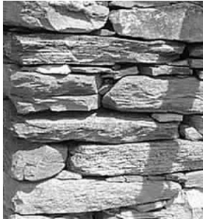
Ausschnitt aus dem Fundament des Steinbaus als typisches Beispiel südalpiner Bauweise
