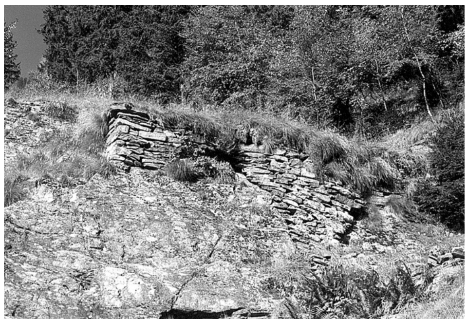
Konstruktions-Beispiel einer Ackerterrasse bei Artoalla
