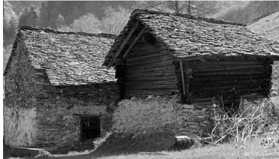
Gesamtansicht der Gebäudegruppe bei Contarescia, Monti die Cauco
