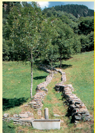
...e dopo il restauro
